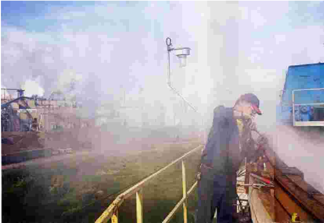
Guy Jalbert répare la rampe d'un réservoir de traitement d'eau usée à l'usine de Trois-Rivières de Kruger Pulp and Paper.
